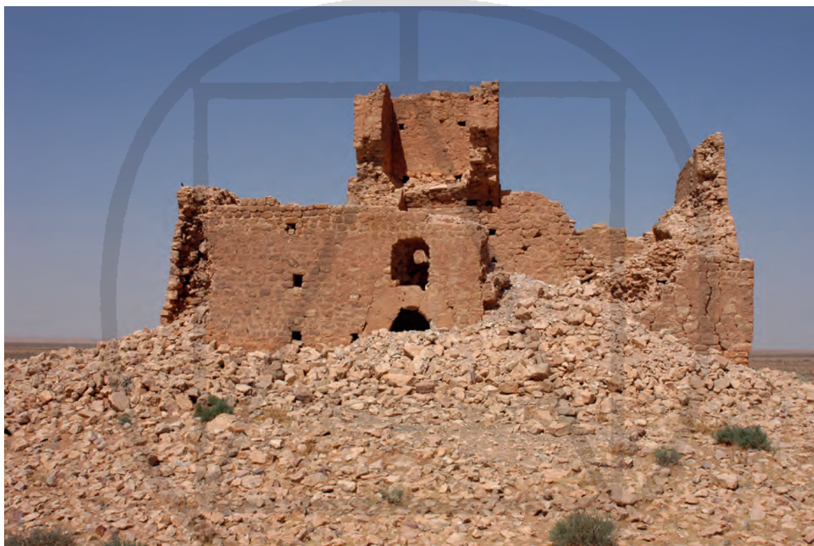
Abb. 5. Gasr Wames, oberes Wadi Sofeggin, Nordwestlibyen. Burgusartige Kleinfestung (centenarium), Zustand 2008. 1 Lage im pre-desert von Nordosten; 2 Ostansicht mit verschüttetem Eingangsbereich und (Aussichts-)Turm; an der Nordmauer (rechts) umlaufende Brüstung mit Zinnenkranz über dem Flachdach des ersten Stockwerks von Osten.
