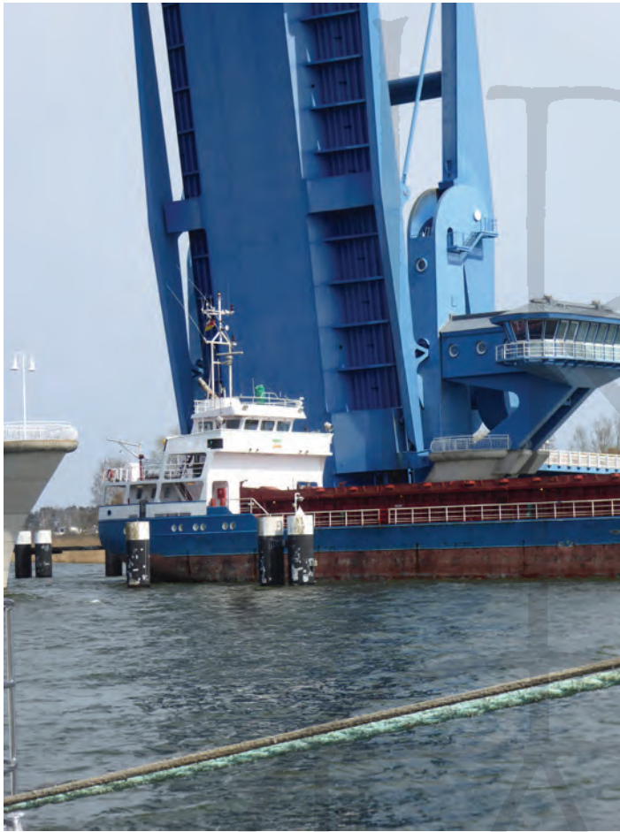
Abb. 6: Ein Frachtschiff durchfährt die hier geöffnete Klappbrücke, die seit 1996 zwischen Wolgast und der Insel Usedom den Peenestrom überquert
